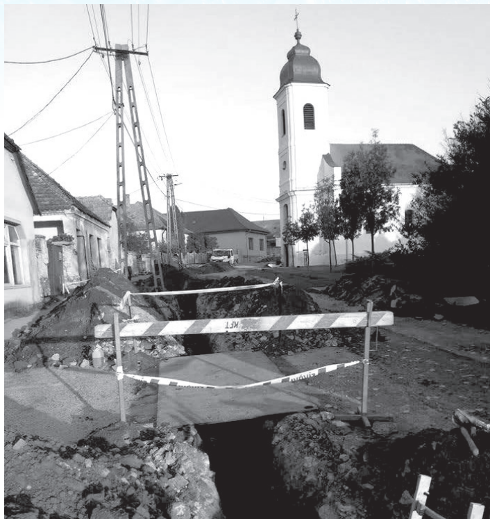
A vízvezeték felújítás „régészeti ásatással” vált
