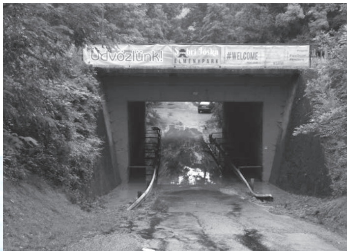
Kislődön a vasúti átjáró szenvedte meg a felhőszakadást
