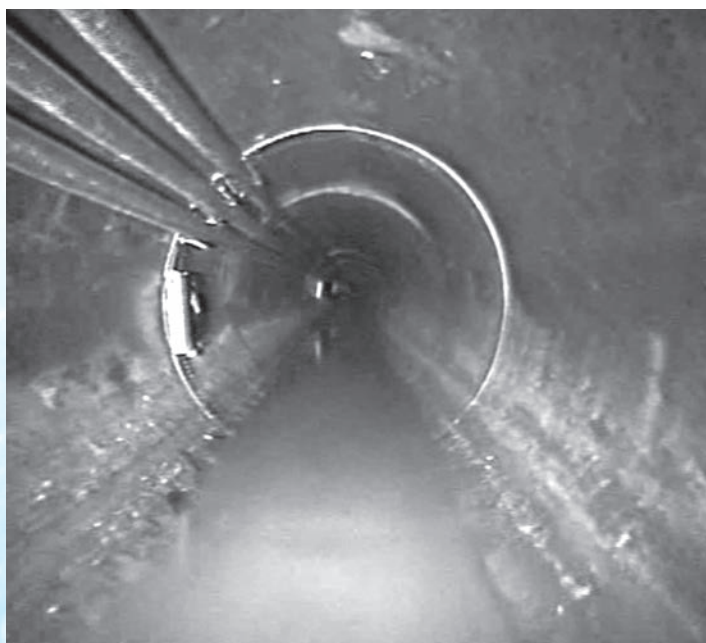
„FAST” rendszer DN400 mm-es csatornában, 3 év üzem után
