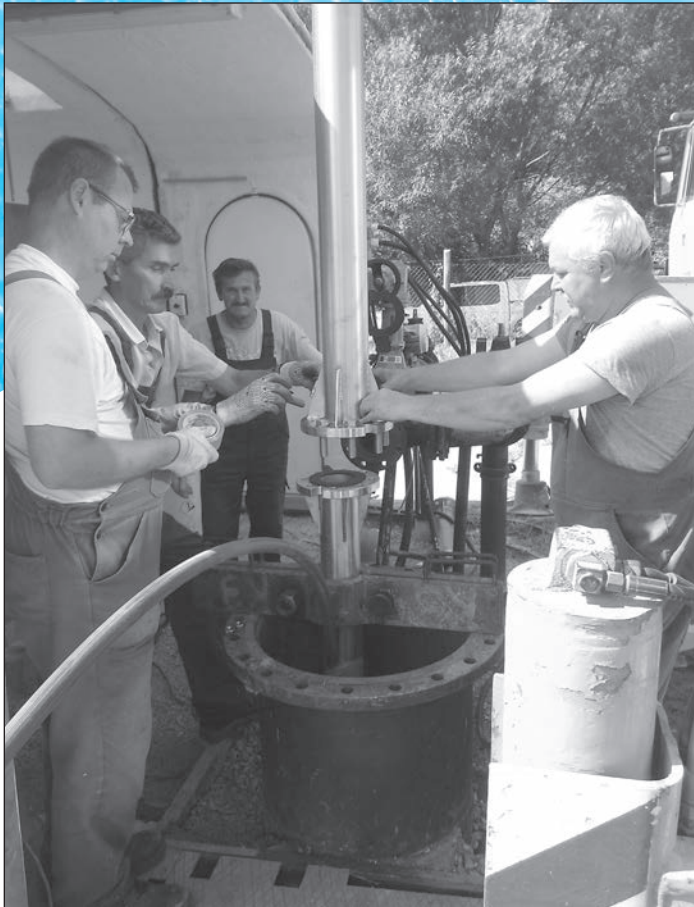
Az „égési sebek” gyógyítása során a CS-81-es kút szivattyúját is cserélni kellett
