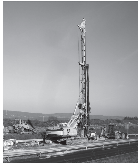
8.sz. főút Várpalota elkerülő szakasz II. ütem, Pétfürdő elágazó építésének kezdete
