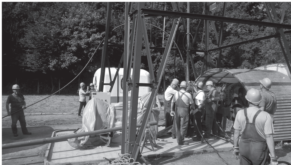
A zirci II. sz. kút kiemelő szerkezete „munka közben”
