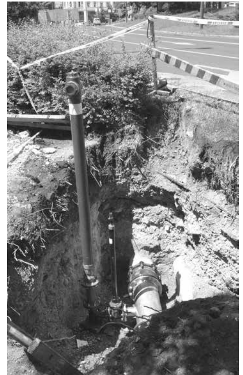
Vezetékfelújítás béleléses technológiával Veszprémben, a Brusznai Árpád utcában
