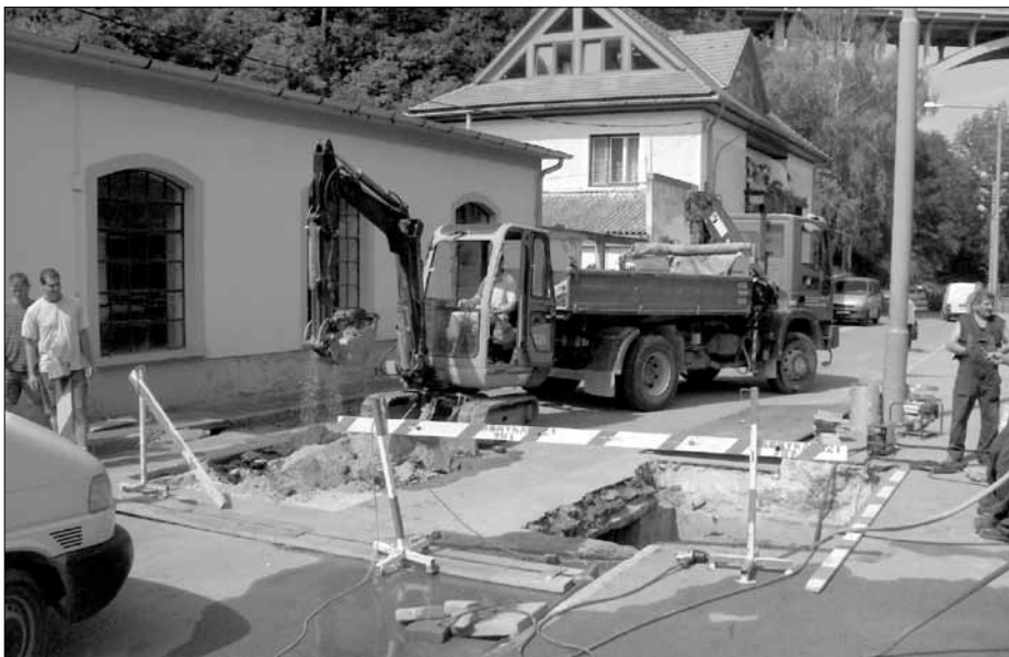
A városi ivóvíz betáplálás biztonságát javítja az az 500-as ivóvízvezeték, amely béleléses technikával újul meg
