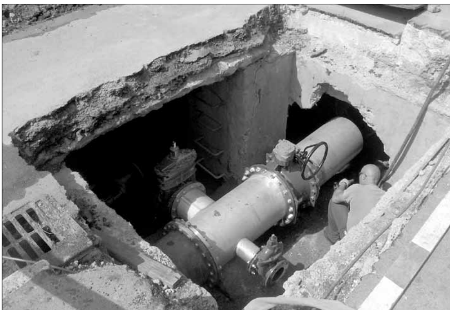
A Kittenberger utcai vezeték korszerű szerelvényeinek beépítése gondos munkát igényel
