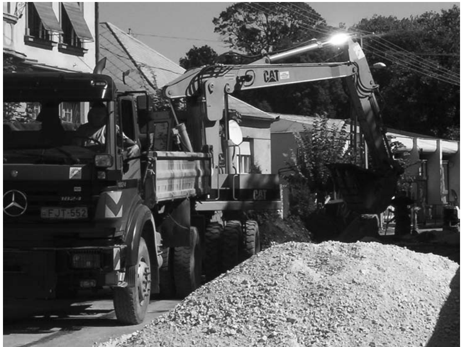
Munkában a csatornaépítők
