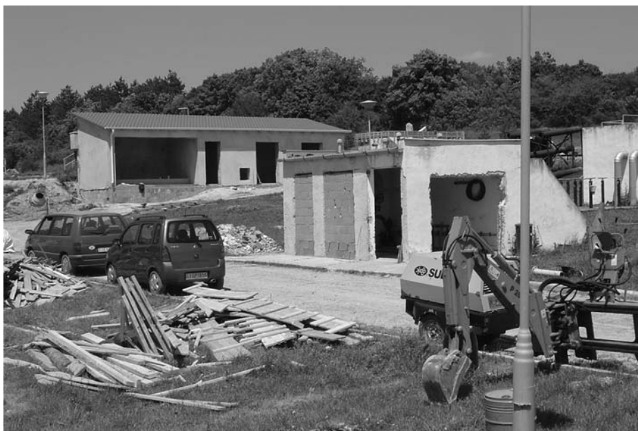
Épülő gépházak (előtérben: iszapvíztelenítő gépház, háttérben: fúvó és vegyszeradagoló gépház)
