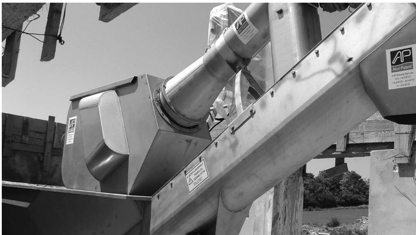
Tetőépítés előtt a rácsgépház
