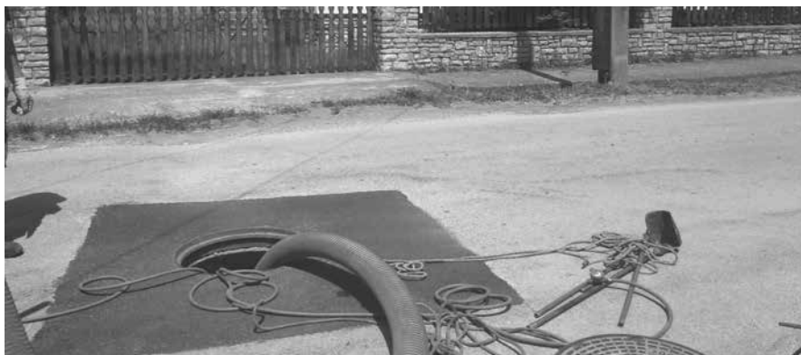
Teljes helyreállítás, víztartási próba
