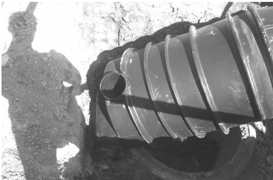
A beton szűkítő elem eltávolítása után behelyezik a 800 mm átmérőjű új aknát
